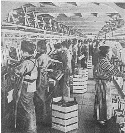
Bild 25. Rückansicht der Haspelanlage von Bild 24.
