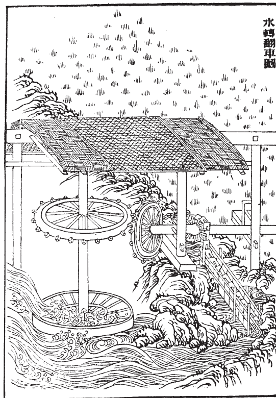
Fig. 14. »Drehkette« für Wasserkraft.
