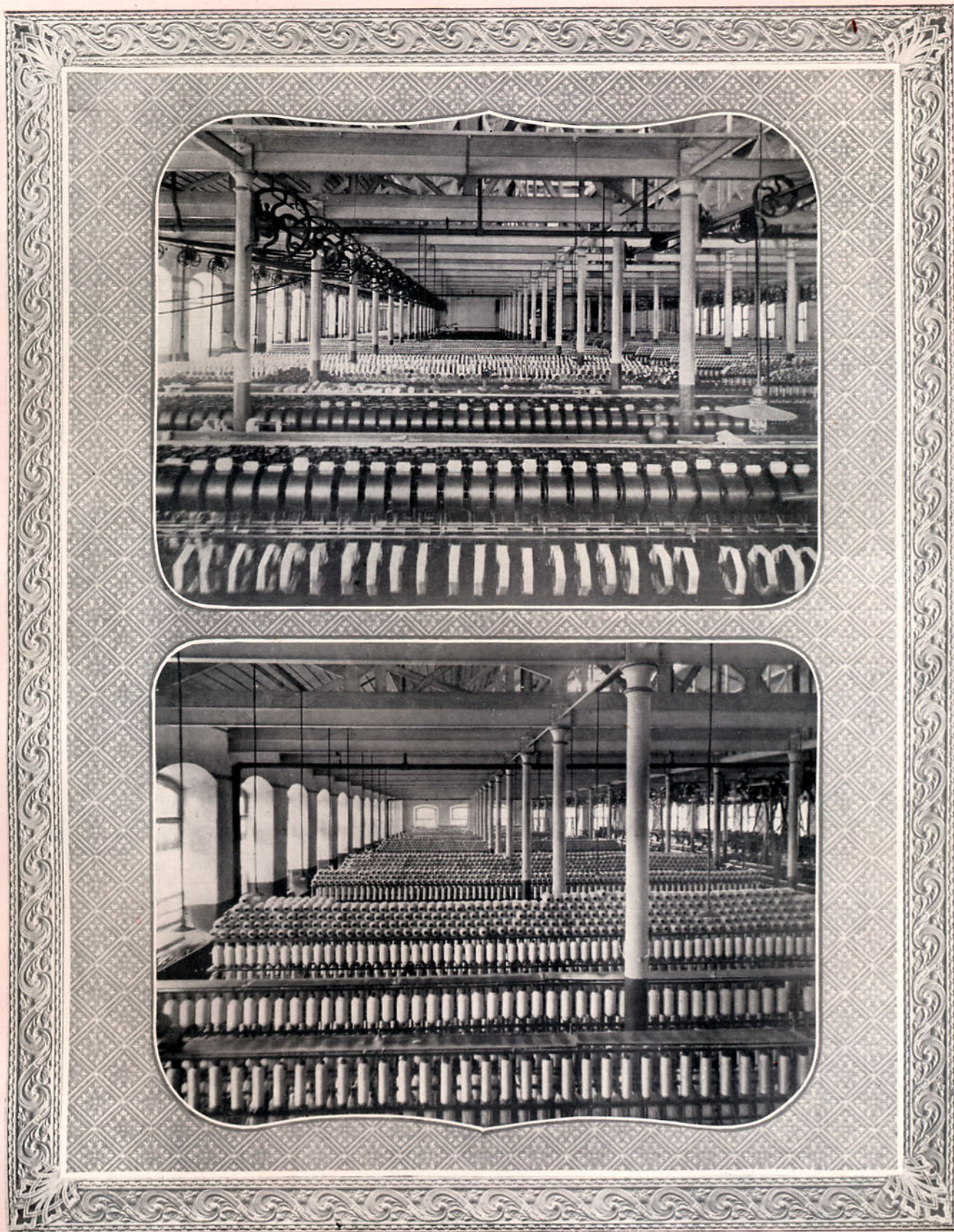
CIA. DE FIAÇÃO E TECIDOS CONFIANÇA INDUSTRIAL, Rio de Janeiro. Aspectos das instalações interiores.
